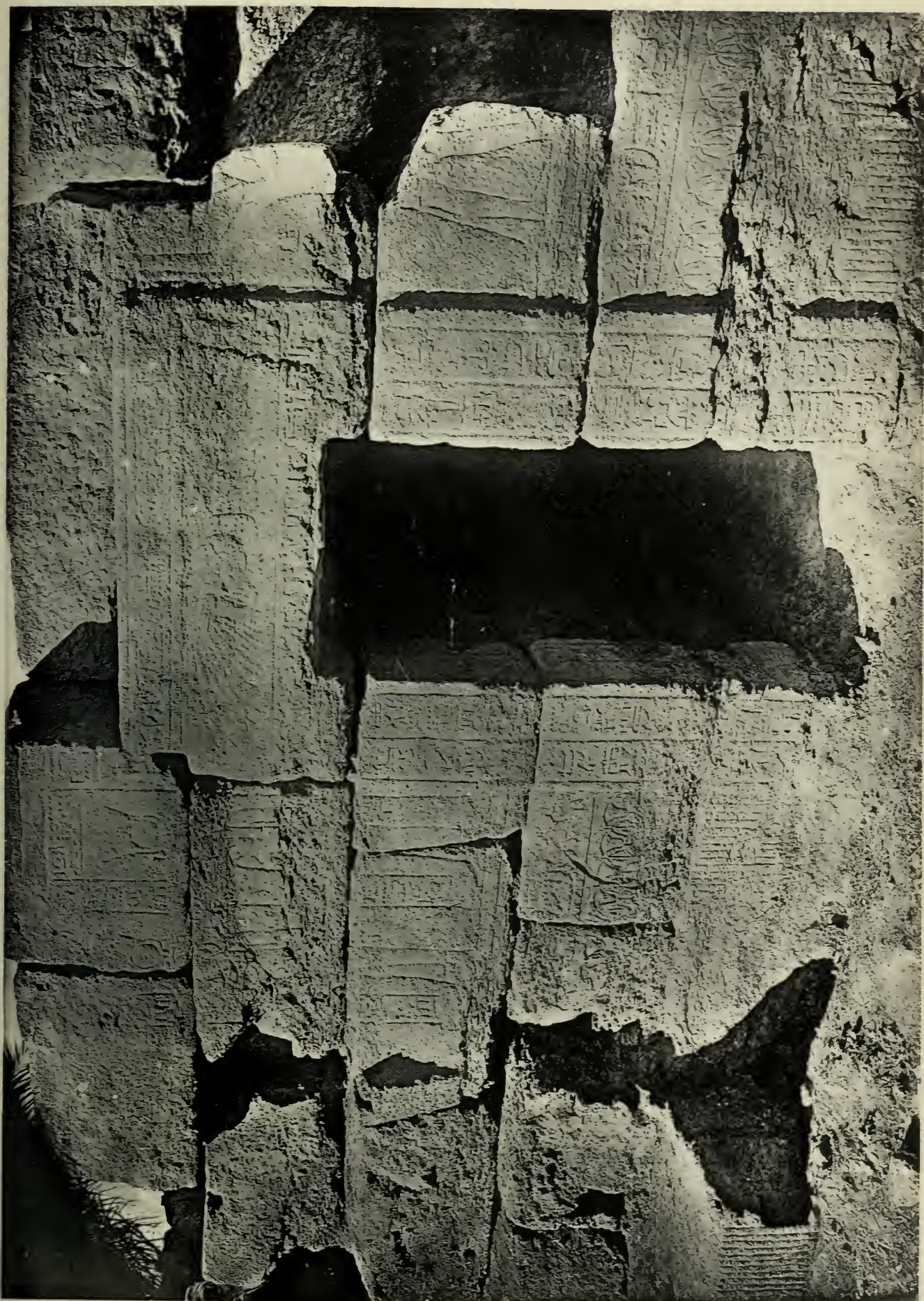
Porte du Mur Extérieur Est.
